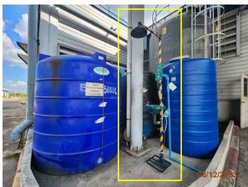
ภาพที่ 2-35 ฝักบัวและอ่างล้างตาฉุกเฉิน
