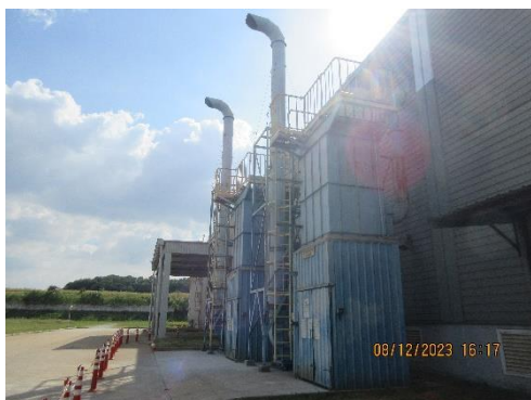
ภาพที่ 2-1 ระบบรวบรวมและดักฝุ่นแบบถุงกรอง
